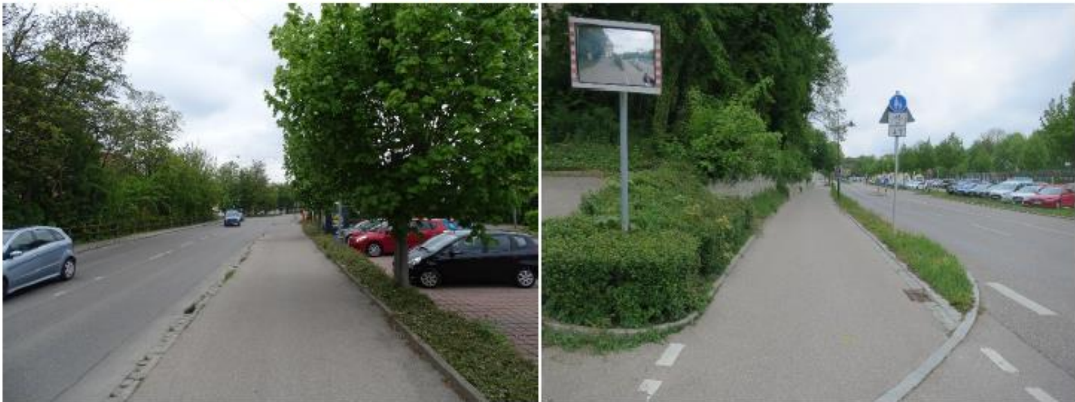
Abb. 63: Fehlender bzw. nicht markierter Sicherheitsraum zur Fahrbahn (links); Baulicher Sicherheitsraum zur Fahrbahn (rechts)
