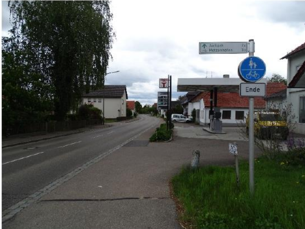
Abb. 60: Fehlende Überleitungen und Querungshilfen am Ende eines 2-Richtungsradweges. Zusätzliches Sicherheitsrisiko bei Kombination mit einer Kreuzung oder Einmündung
