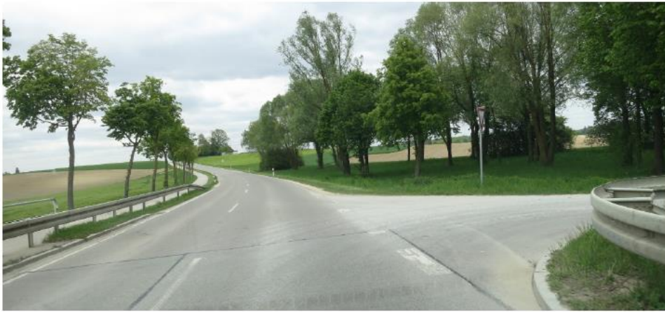
Abb. 55: Die notwendige Querung der Fahrbahn ist an dieser Stelle nicht möglich
