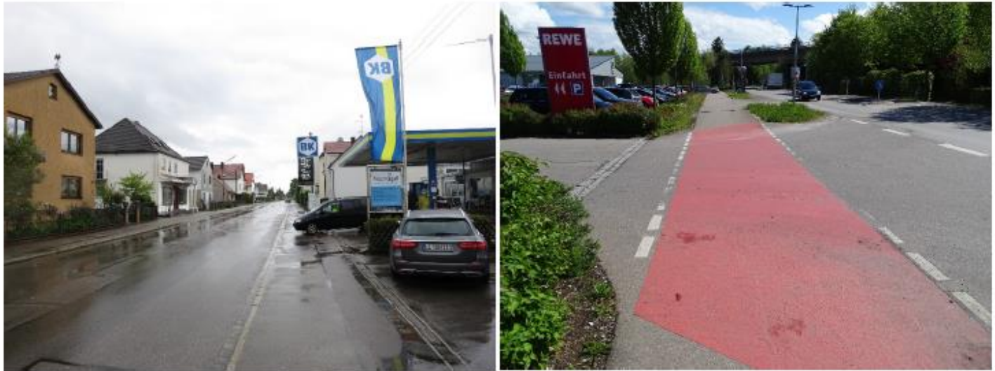
Abb. 66: Ungesicherte und gesicherte Zufahrten
