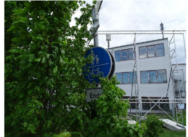
Abb. 49: Erkennbarkeit eines VZ durch Bewuchs eingeschränkt
